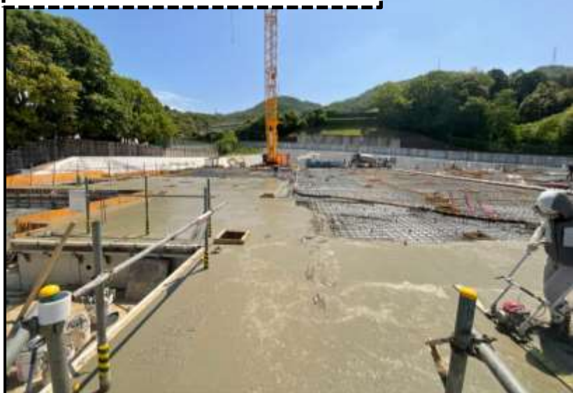
令和7年6月の給食センター工事の様子
