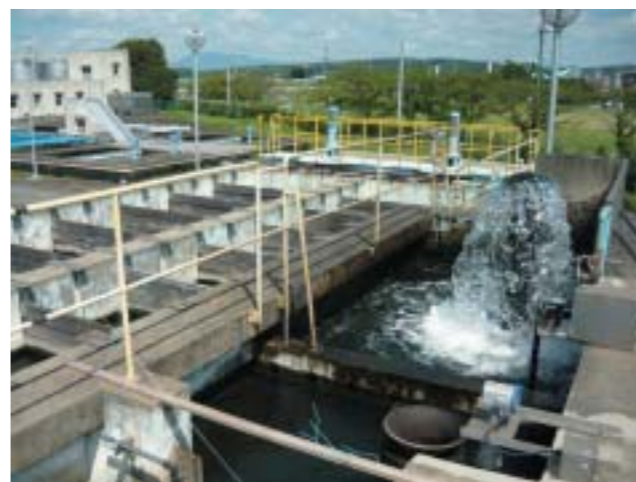
水処理施設（着水井）
