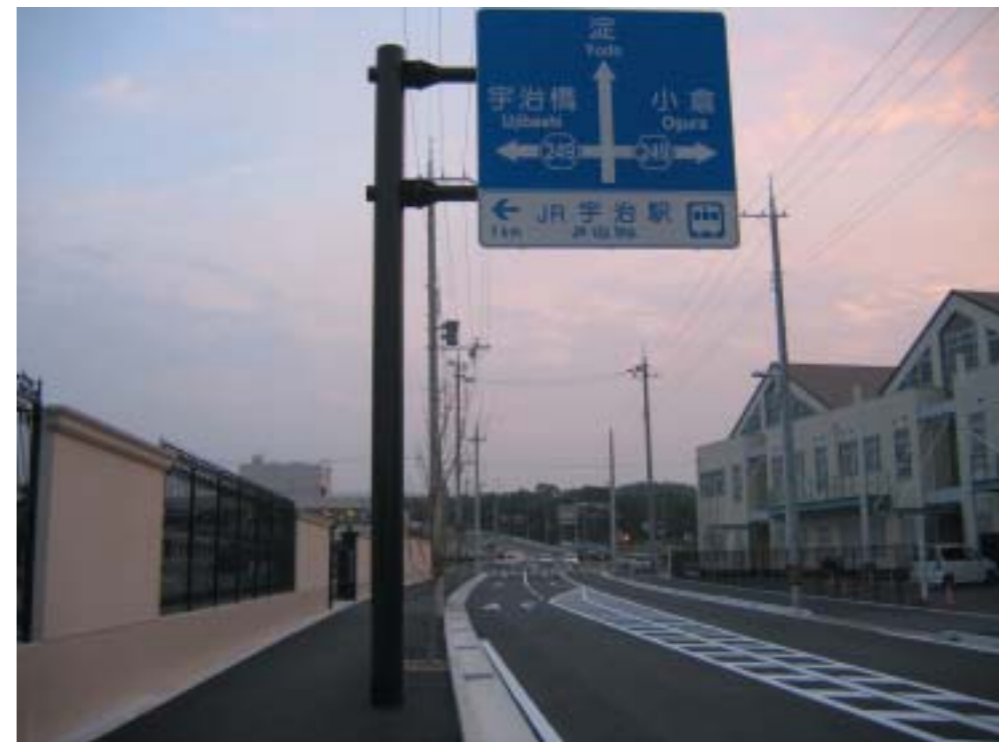
市道宇治槇島線供用箇所
