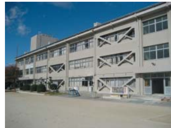
校舎の耐震補強の様子
