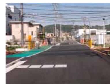
踏切拡幅（折坂三番割線）
