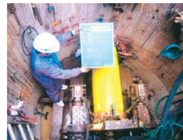
下水道工事(推進工法)
