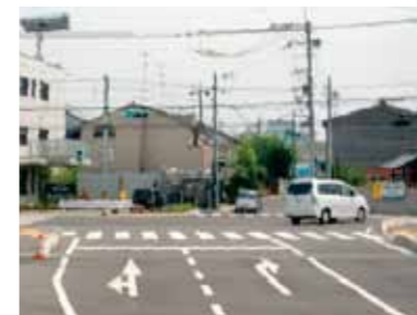
橋梁拡幅（遊田線）
