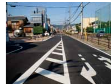
道路拡幅（小倉安田線）
