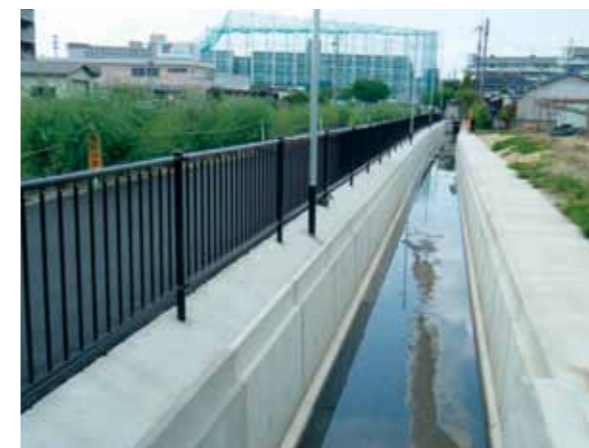
槇島17号排水路
