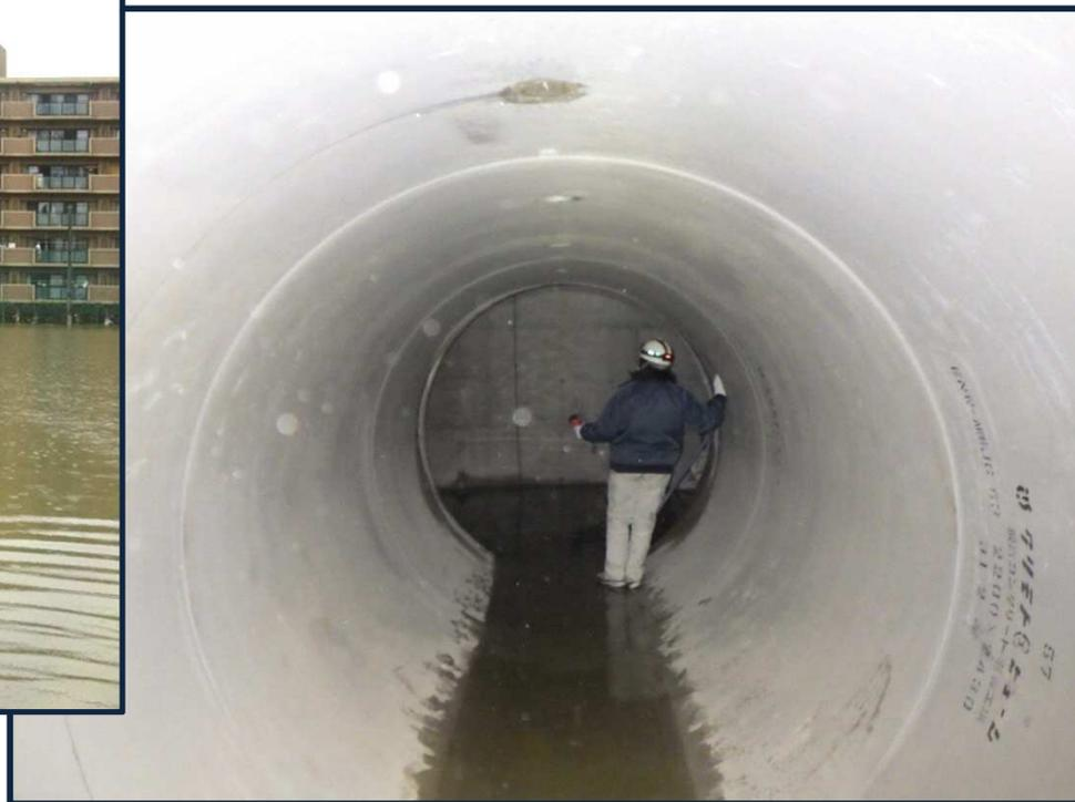
(雨水貯留管の内部:直径 = 2.2m)
