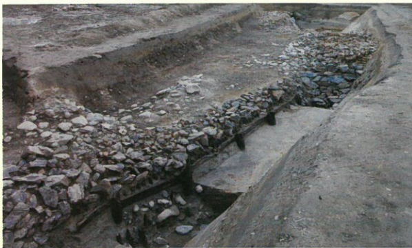
写真1 杭止め護岸(位置図⑦)
