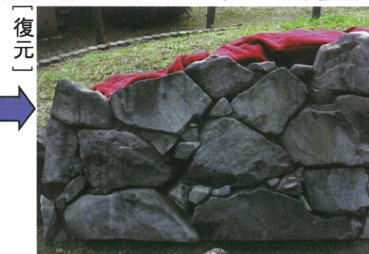
太閤堤 型取り
