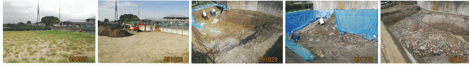
3 トレンチの調査風景
