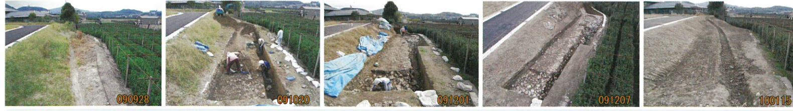
2 トレンチの調査風景
