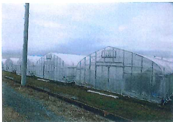
リース利用しているパイプハウスの写真
