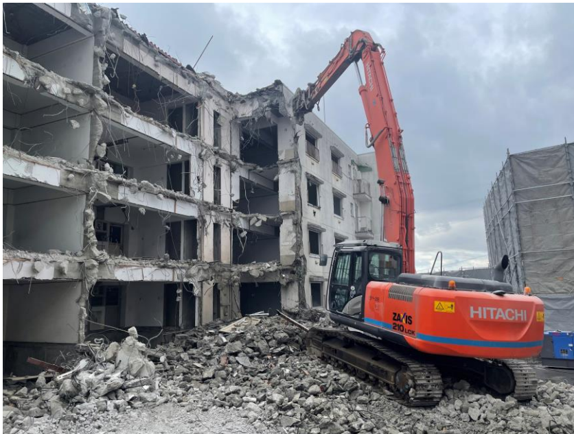
4階建て建物解体作業
