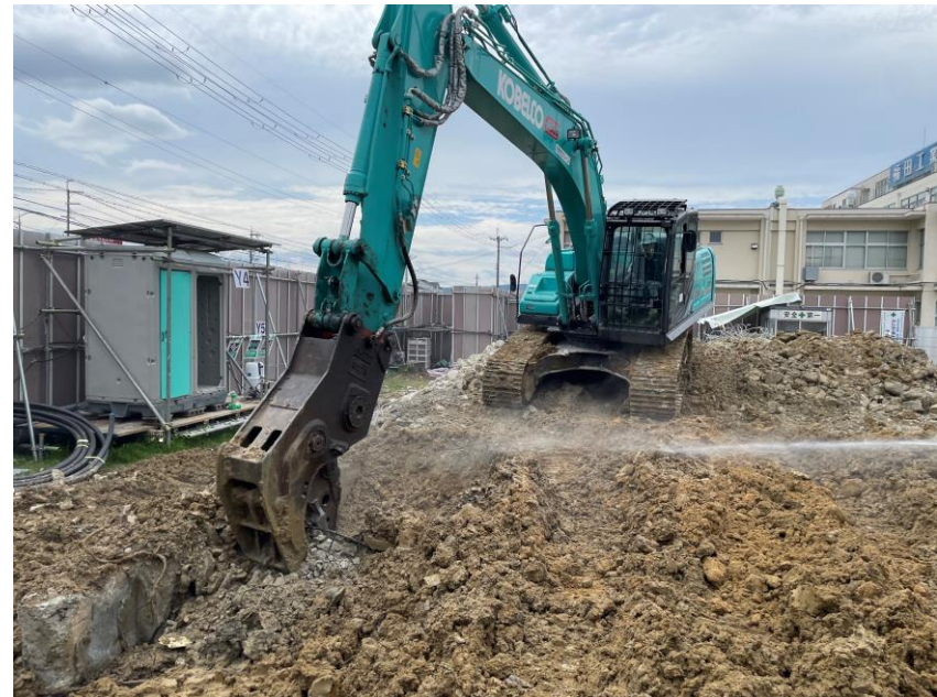
コンクリート小割り作業
