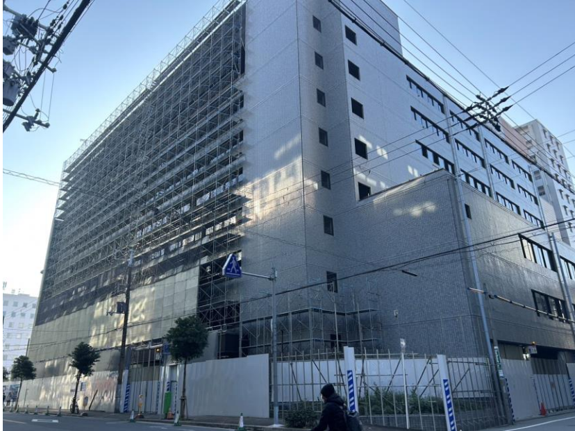
建物周囲に足場設置
