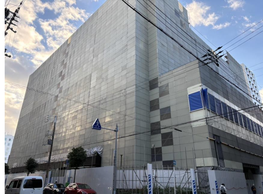
防音パネル張り
