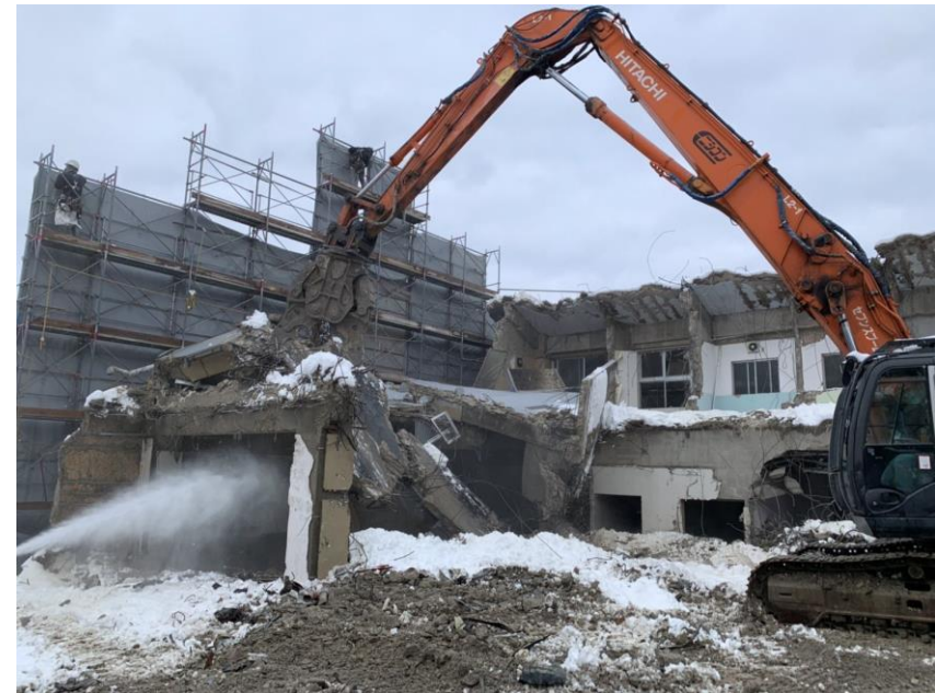
散水しながら解体作業
