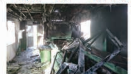
リチウムイオン電池等の充電池や電化製品、タバコなどが混入して発生した火災 (©2021日本経済新聞社/写真:高橋 浩二)
