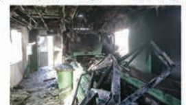
リチウムイオン電池等の充電池や電化製品、タバコなどが混入して発生した火災 (©2021日本環境出版社/イデア)
