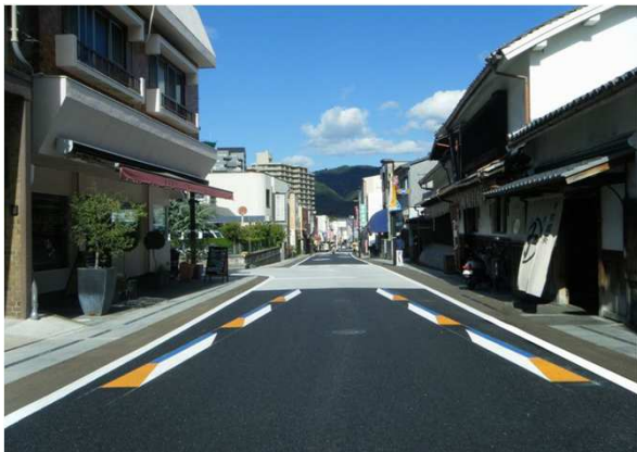
無電柱化事業が実施された宇治橋通り
