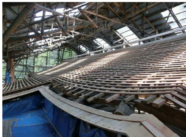
宇治上神社 屋根修理状況
