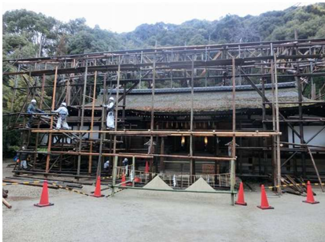
宇治上神社 素屋根設置状況
