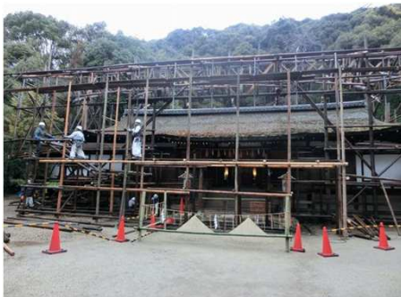
宇治上神社 拝殿の修理状況
