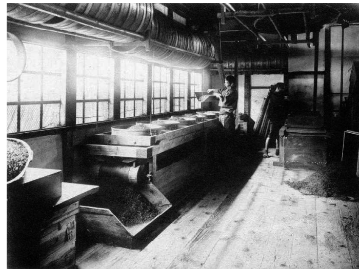
『京都府久世郡写真帖』 第八十八 製茶切断器及平行篩
