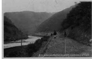
151 宇治川電気株式会社工事用 運搬道路（南郷・県道拡築）工事
