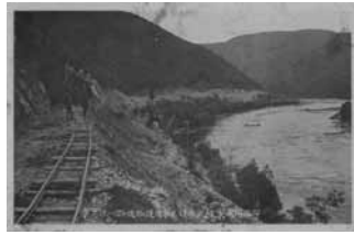
148 宇治川電気株式会社工事用 運搬道路（二尾）工事
