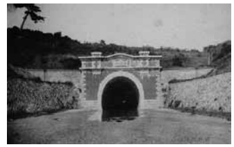
207 神戸新湊川のトンネル
