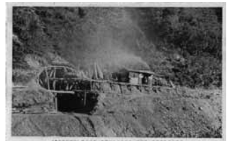
154 宇治川電気会社第七号隧道 西口工事（宇治村字菟道）
