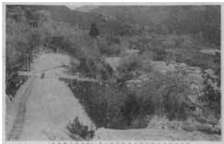
152 宇治川電気会社工事用運搬 道路工事（宇治村字志津川）
