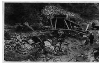
153 宇治川電気会社第八号隧道 東口工事（宇治村字菟道）
