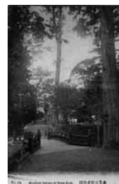
263 奈良公園水谷橋
