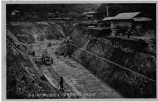
150 宇治川電気株式会社第一号 隧道西口（外畑）工事
