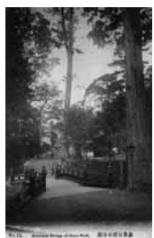
264 奈良公園水谷橋
