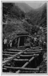
147 宇治川電気株式会社第七号 隧道東口（二尾）工事
