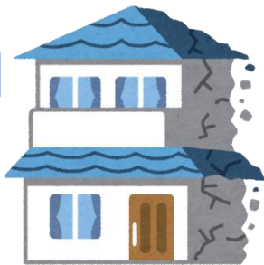
管理不全空き家
