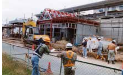
▲建設中のJR六地蔵駅【平成4年撮影】
