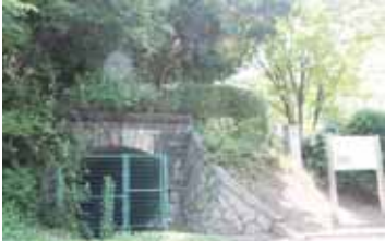
▲黄檗プールと野球場に挟まれた場所に、ひっそりと当時のトンネルが残されています。
