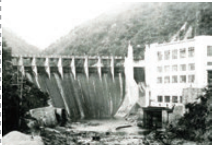
昭和2年(1927年)完成の大峰発電所(右の建物)と大峰堰堤。 現在は、高さ15メートル以上のものをダム、これより低いものを堰堤と呼びますが、かつてはその区別は無く、大峰は高さ26メートルですが、堰堤と呼ばれていました。
