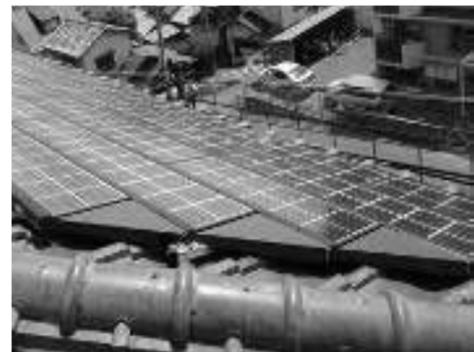
屋根面と太陽光パネルの段差を目立たせないような措置を施します。
