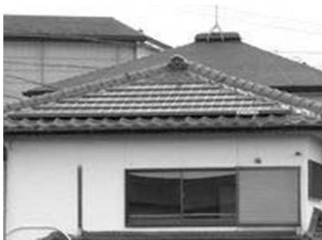
設置範囲を屋根の形状に合わせて段状に設置します。
