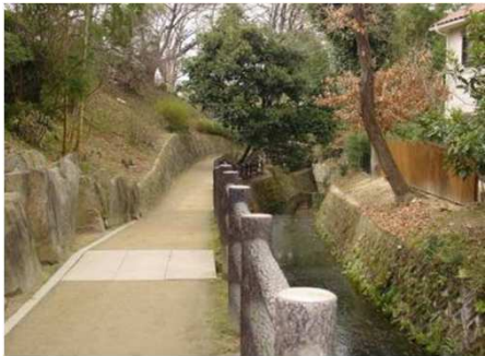
[現況写真] 上流部散策道整備済区間の状況
