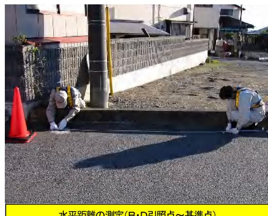
水平距離の測定(B・D引照点～基準点)
