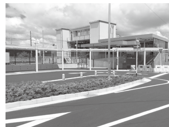
駅前広場整備（J R 新田駅東口）
