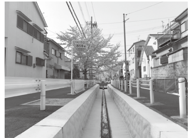
排水路改修（小倉5号排水路）
