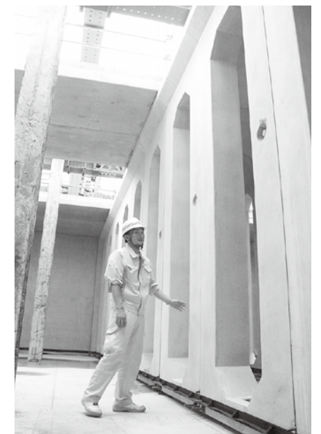
雨水貯留施設内部
