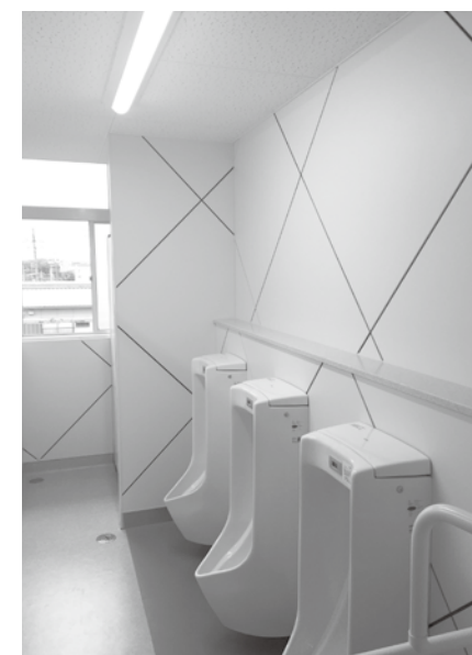
学校のトイレ整備
