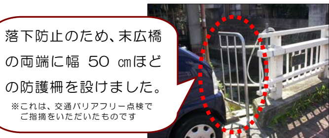
▲末広橋北側の防護柵
