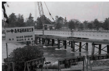
工事中の朝霧橋 昭和46(1971)年
