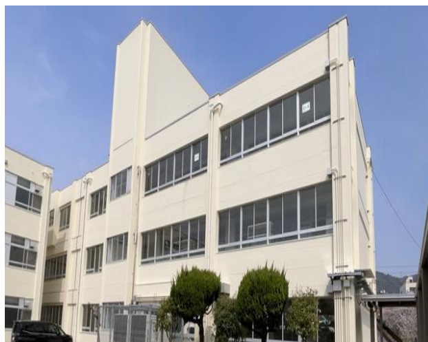
＜東宇治中学校長寿命化事業(外壁改修)＞
