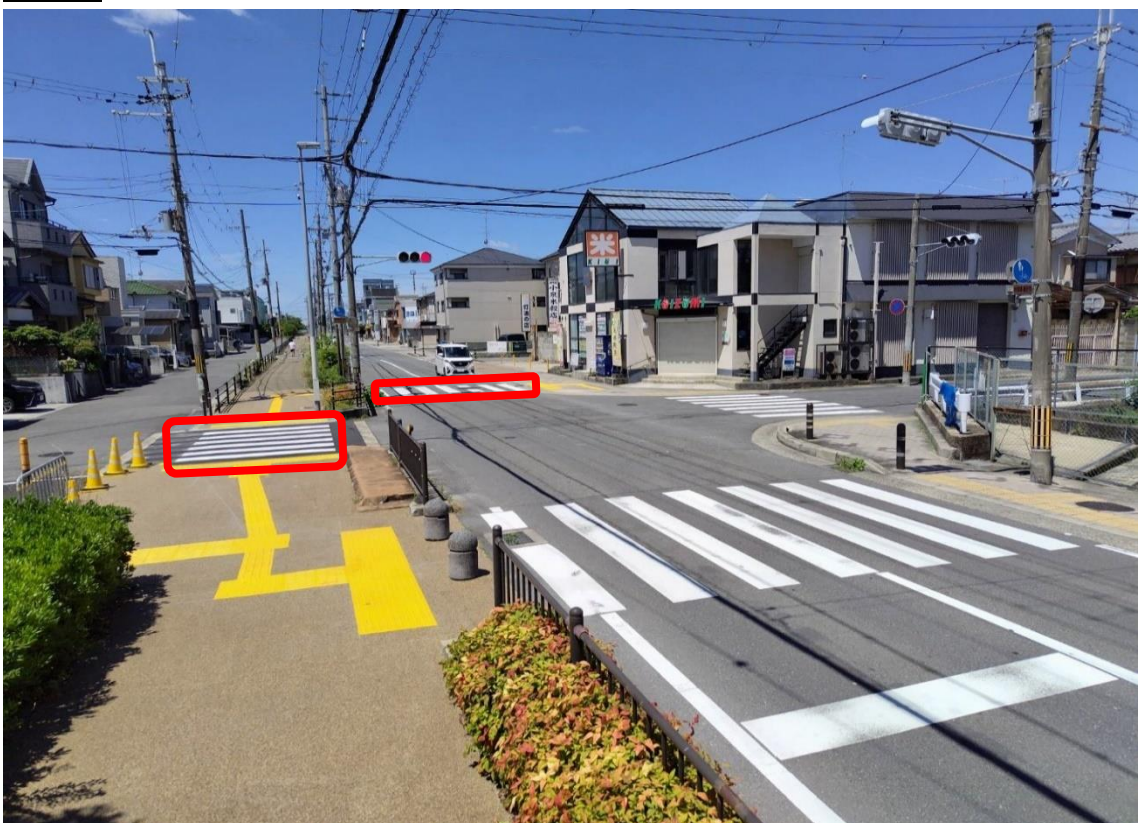
横断歩道 2 箇所を新設し、歩道の切り下げを実施
