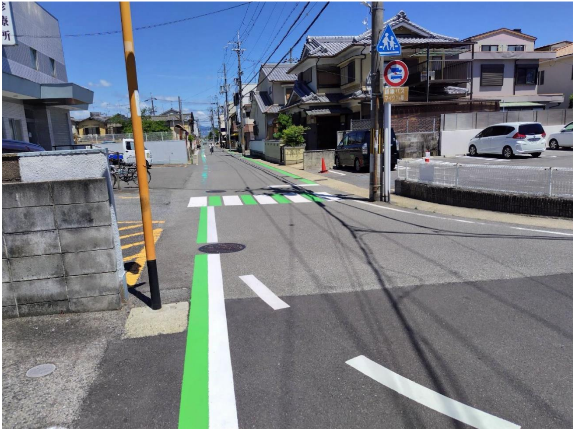
外側線・グリーンベルト、誘導線の設置や横断歩道のカラー化を実施
