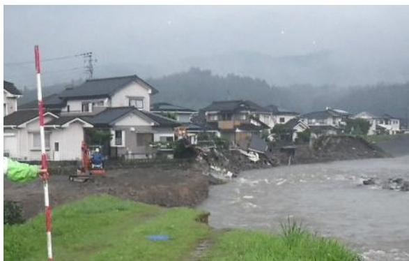
河岸侵食による家屋の倒壊(花月川)
