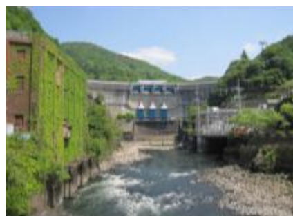
宇治川天ヶ瀬ダム
