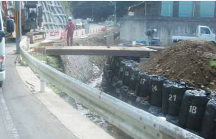
▲炭山地区の滝ノ元川での応急復旧 (河川等災害復旧事業費)
