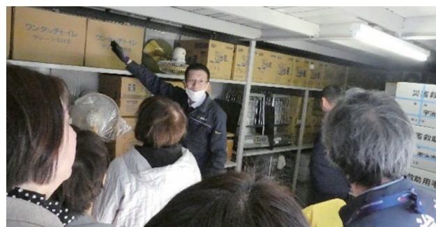
<② 小学校防災備蓄倉庫>
