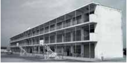
▲昭和32年12月に完成した西宇治中学校校舎。鉄筋コンクリート造は南山城地域の中学校でも初めてでした。
