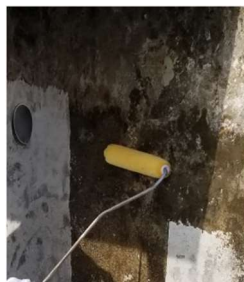
【塗布型当て板工】
