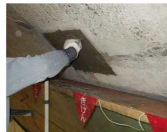
断面修復工 <対策工の例>
