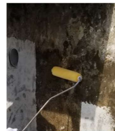
塗布型当て板工
