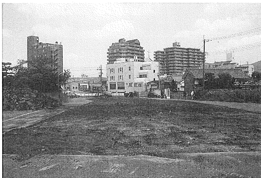
3. アスファルト除去後 （東から）
