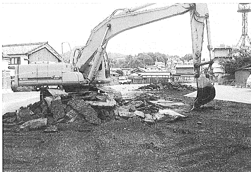
2. アスファルト除去 作業中（西から）
