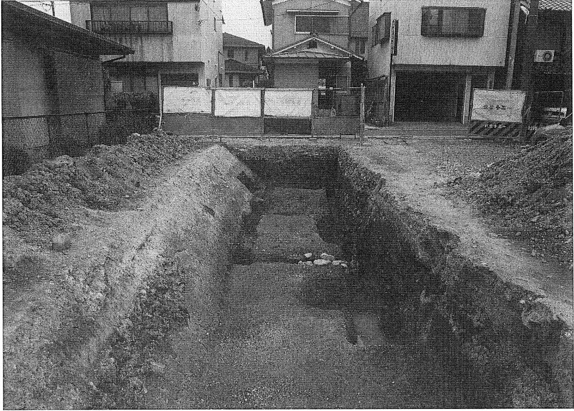
1. B トレンチ全景（北から）
