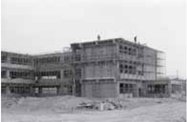
▲昭和49年4月の開校に向けて進む伊勢田小学校の建設工事
