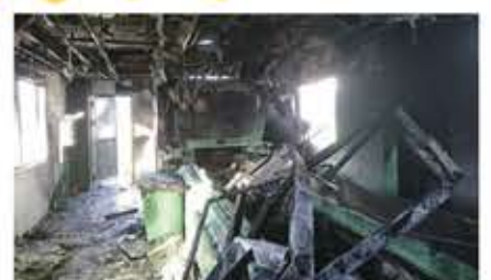
リチウムイオン電池の発火が原因で、リサイクル工場が焼けてしまった事例 (公財)日本資源再生リサイクル協会より
