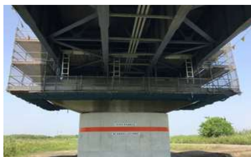
各橋脚部での吊り足場 (写真はイメージ)
