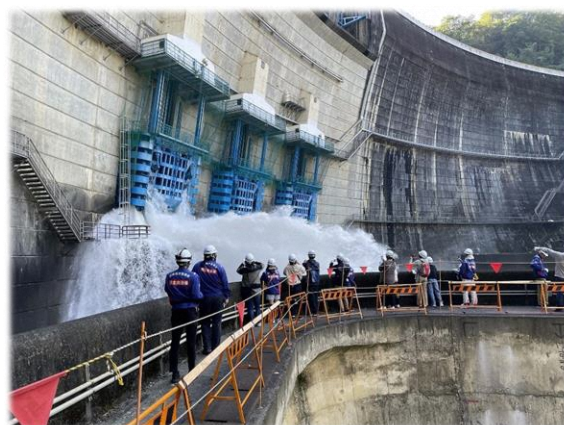
天ヶ瀬ダム探検ツアー
