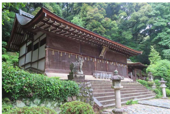
写真 5 - 41 (①) 宇治上神社本殿 及び石積み・石階段
