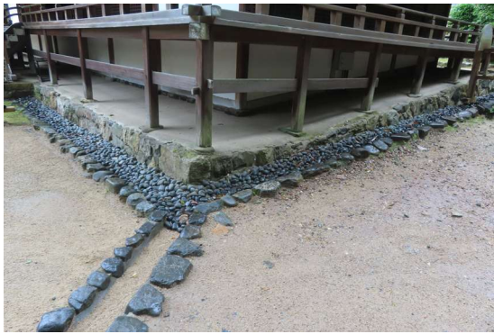
写真 5 - 59 (⑨) 拝殿雨落ち溝、排水溝
