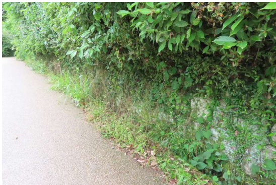
写真 5 - 77 (⑨) 境内地外周扱い石積み
