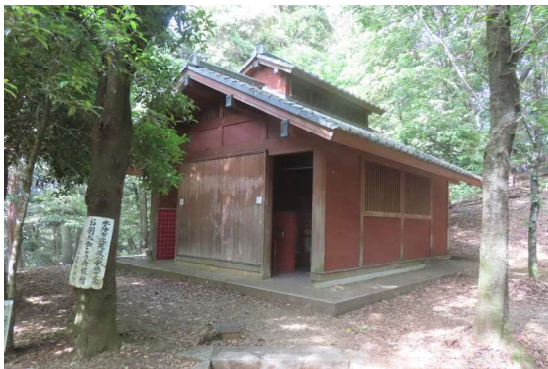
写真 5 - 19 (16) 大吉山風致公園公衆トイレ
