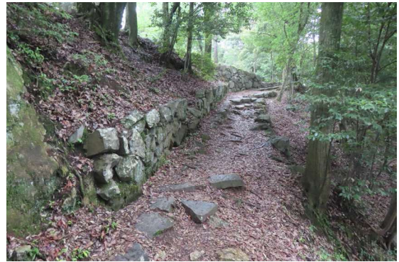
写真 5 - 32 (29) 朝日山登山道石段、石積み
