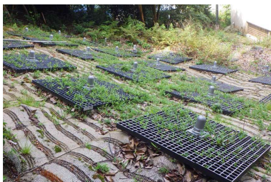
写真5-6 (③) 二子山における被災後の 土留め工
