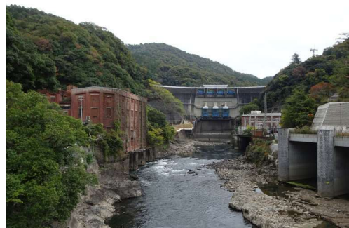
写真2-12 志津川発電所跡（左）と天ヶ瀬ダム（奥）
