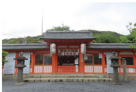
写真 2 - 16 宇治神社本殿（重要文化財）
