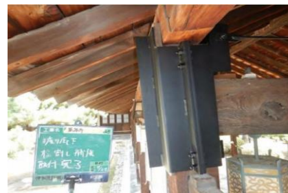
萬福寺 回廊柱割れ補強
