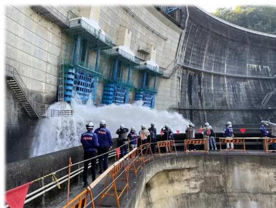
天ヶ瀬ダム探検ツアー
