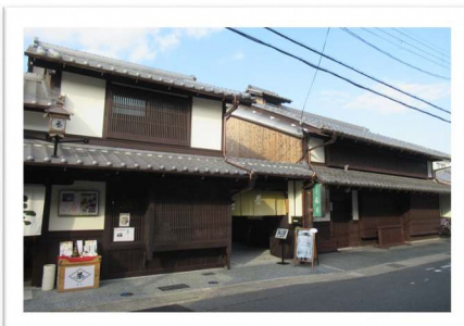
茶問屋(景観重要建造物)
