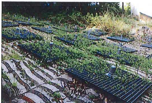
③ 二子山における被災後の土留め工
