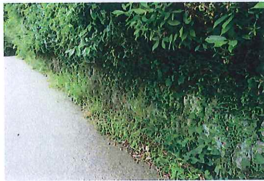
⑨ 境内地外周沿い石積み
