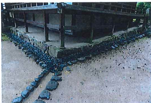
⑨ 拝殿雨落ち溝、排水溝
