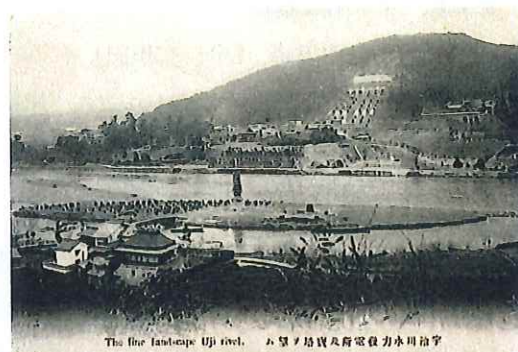
図3-11 宇治川水力発電所及寶塔ヲ望ム (絵葉書、明治45年(1912)頃)
