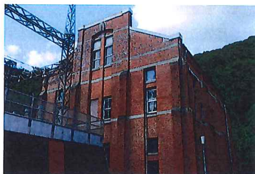
② 発電所建屋
