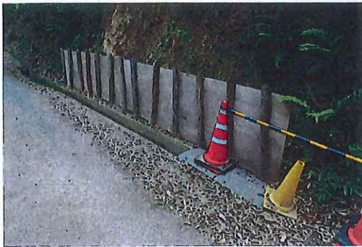
④ 市道宇治6号線沿い土砂崩れ応急処置
