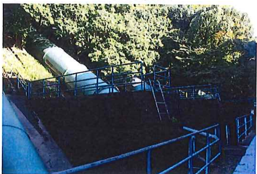
③ 水圧鉄管と周辺の植栽
