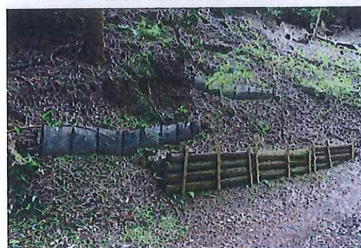
③⑪ 土留め工
