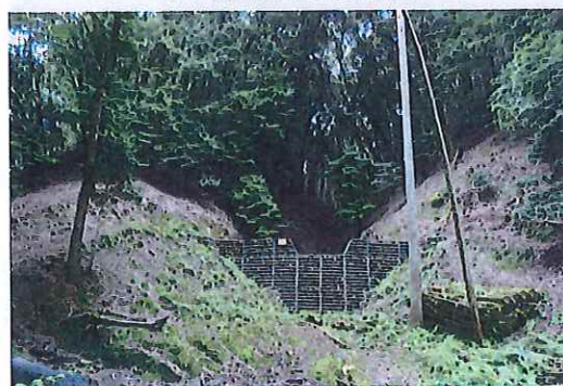
③⑩ 治山堰堤
