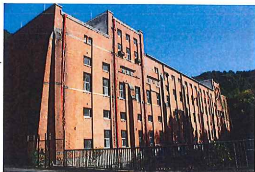
① 発電所建屋
