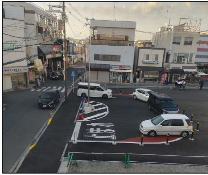
駅前広場(西口)暫定整備
