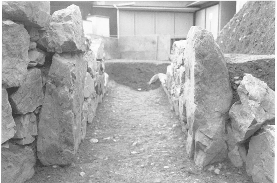
石室玄室部玄門（北西から）
