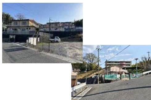
宇治東山市営住宅 現地状況
