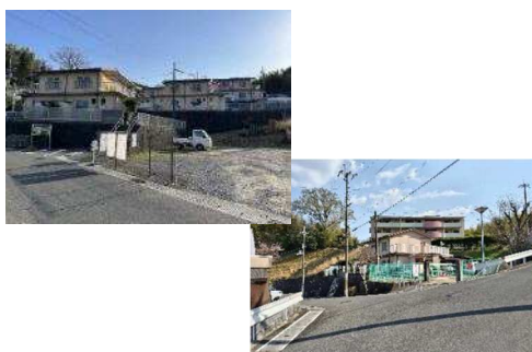
宇治東山市営住宅 現地状況
